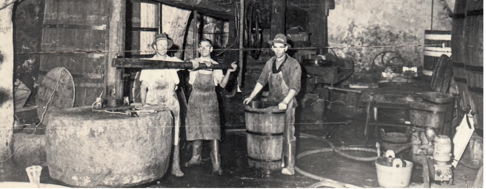
Mit dieser mächtigen Torggl presse man über Jahrhunderte die Trauben aus. | Questo possente torchio è stato usato per secoli per pressare l'uva. | This mighty press called torggl was used to press the grapes for centuries.
